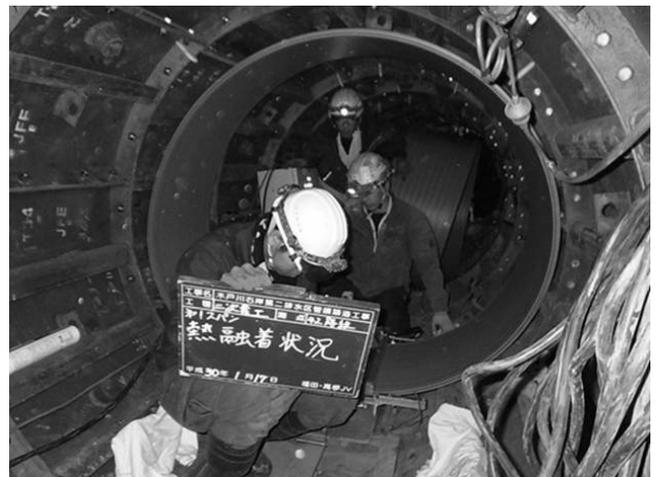
写真4 坑内ライニング施工状況
