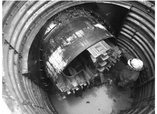
写真3 掘進機到達状況
