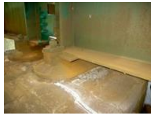
写真6 化粧モルタル撤去及び水切り溝施工
