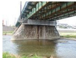
写真7 吊り足場設置
