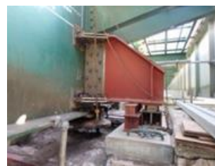
写真9 桁の仮受の状況
