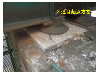
写真2 沓座および桁座の変状
