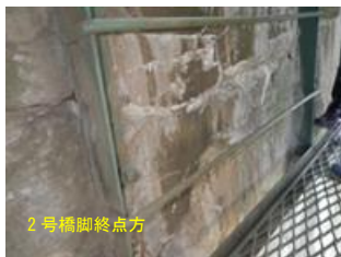
写真1 桁座のひび割れ
