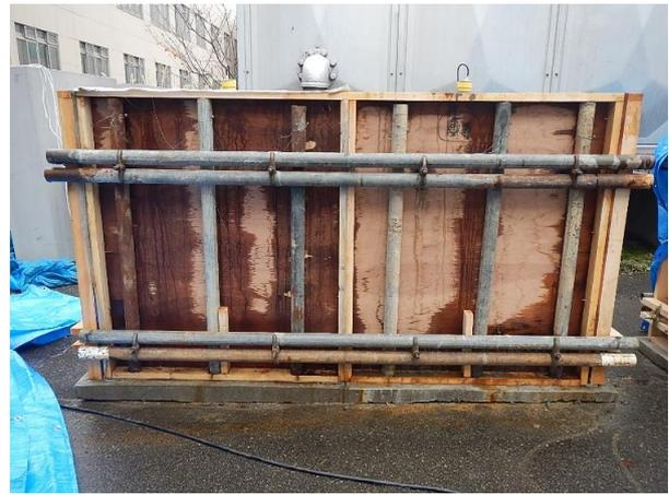
図-3 型枠外面の湿潤状況
