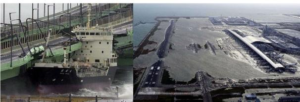
図-2 (左) 走錨による連絡橋衝突, (右) 関西国際空港の浸水
