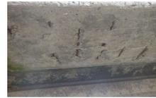
写真-3 主桁損傷部
