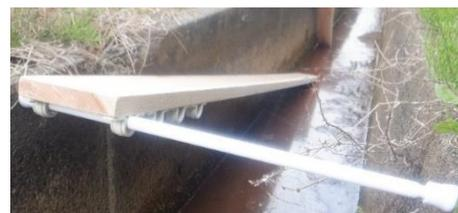
写真-6 ヒンジ式突っ張り棒タイプの脱出装置
