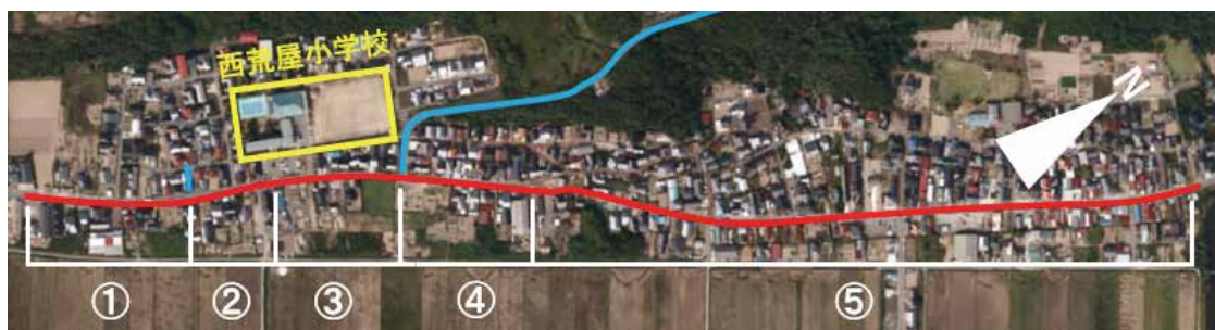
図-8 対象場所の地盤変状箇所
