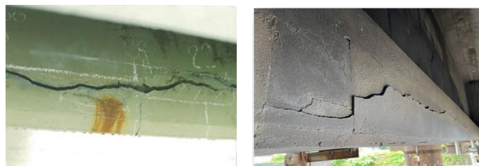
写真 1. 下フランジ側面のひび割れ状況（左：1995 年 右：2023 年）
