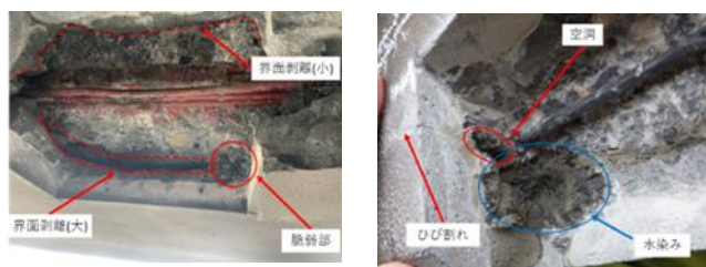
写真 2. 変状箇所のはつり断面状況
