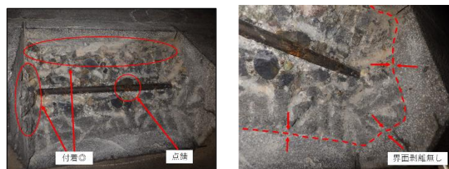
写真 3. 健全部のはつり断面状況
