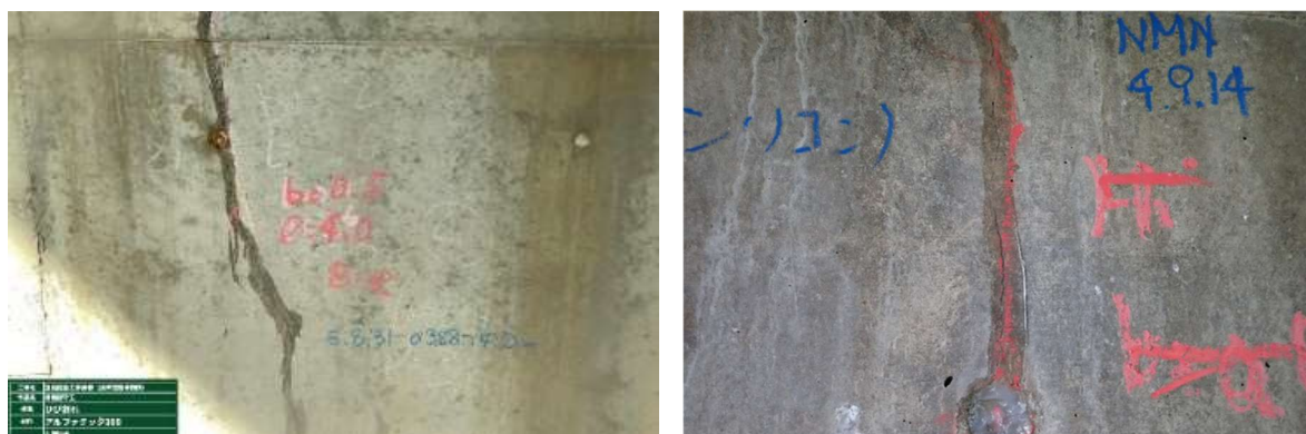
図-2 接着材施工状況およびウレタン系施工状況
