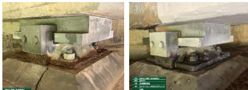
図-4 黒さび転換系 施工前・後
