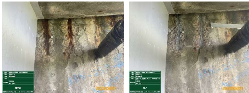
図-3 塩分吸着材入防錆+表面保護 施工前・後
