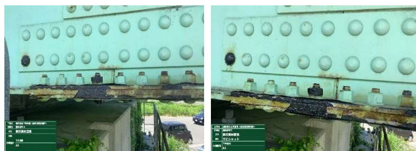
図-5 素地調整軽減型 施工前・後
