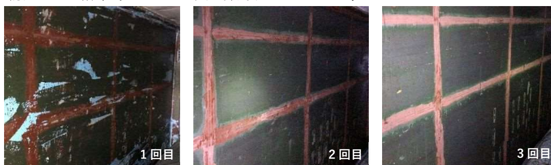
図-2 塗膜剥離剤の使用による塗膜剥離状況
