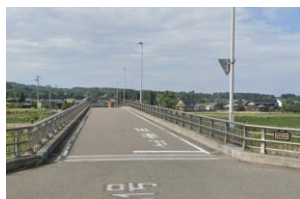
写真-2 下位の橋の例(0.95)
