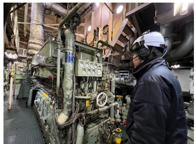
図-9 機関部点検状況
