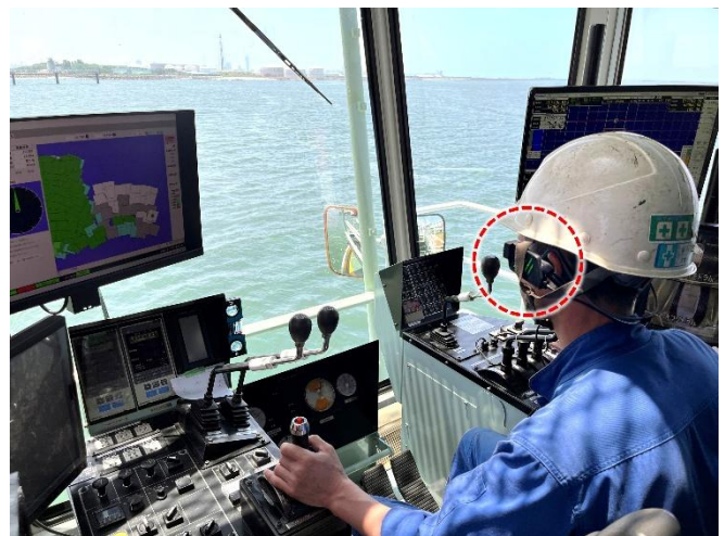
図-4 重錘均し作業状況
