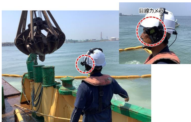
図-2 基礎捨石投入作業の撮影状況
